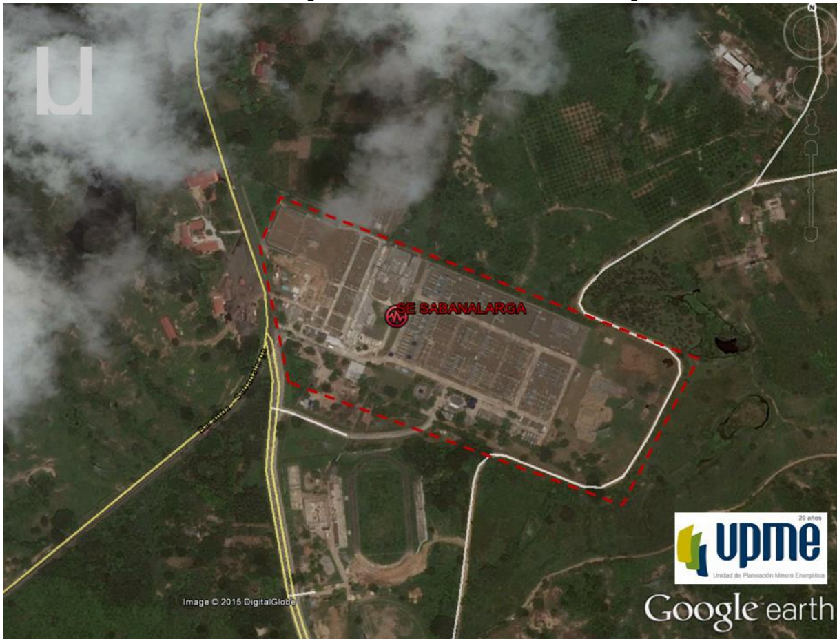
Gráfica 6-127: Localización general de la Subestación existente Sabanalarga 500/220 kV.
