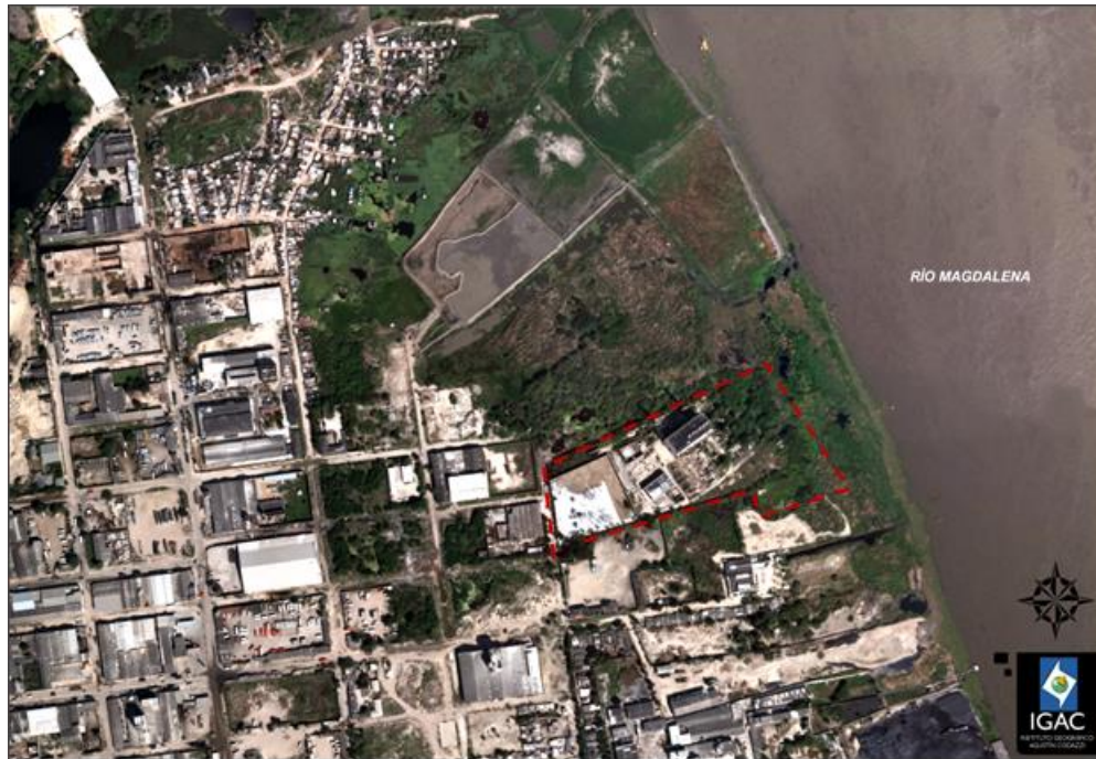
Gráfica 6-117: Localización general de la Subestación existente El Río 110 kV.
