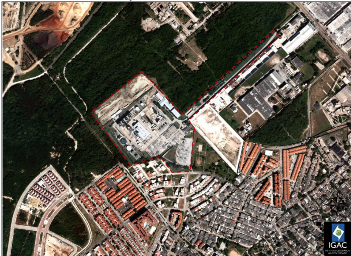
Gráfica 6-113: Localización general de la Subestación existente Termoflores 220/110 kV.
