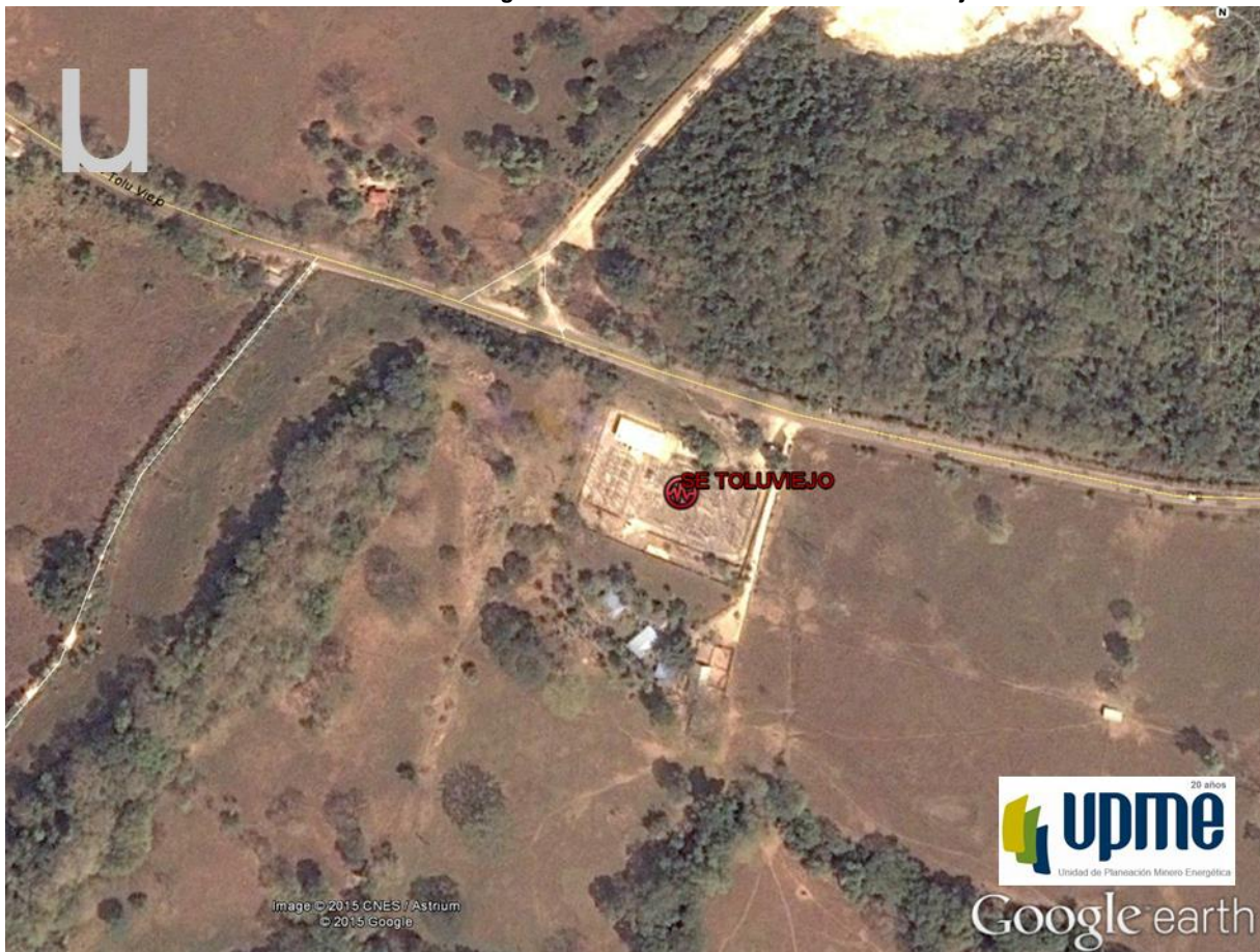
Gráfica 6-143: Localización general de la Subestación existente Tolviejo 110 kV.
