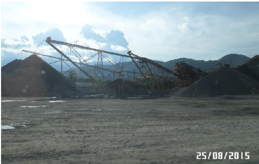
Fotografía 17-7 Acopio y beneficio (Gravicon)
