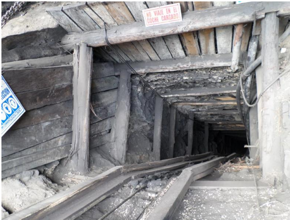
Fotografía 11-5 Ingreso a la mina
