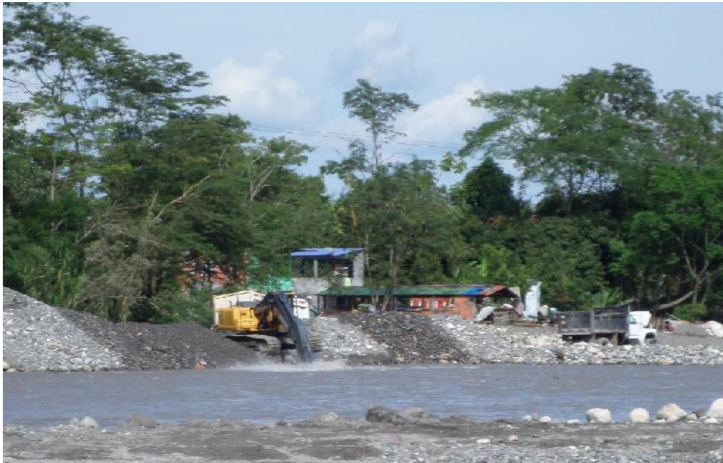
Fotografía 17-1 Extracción de Material Mintracol
