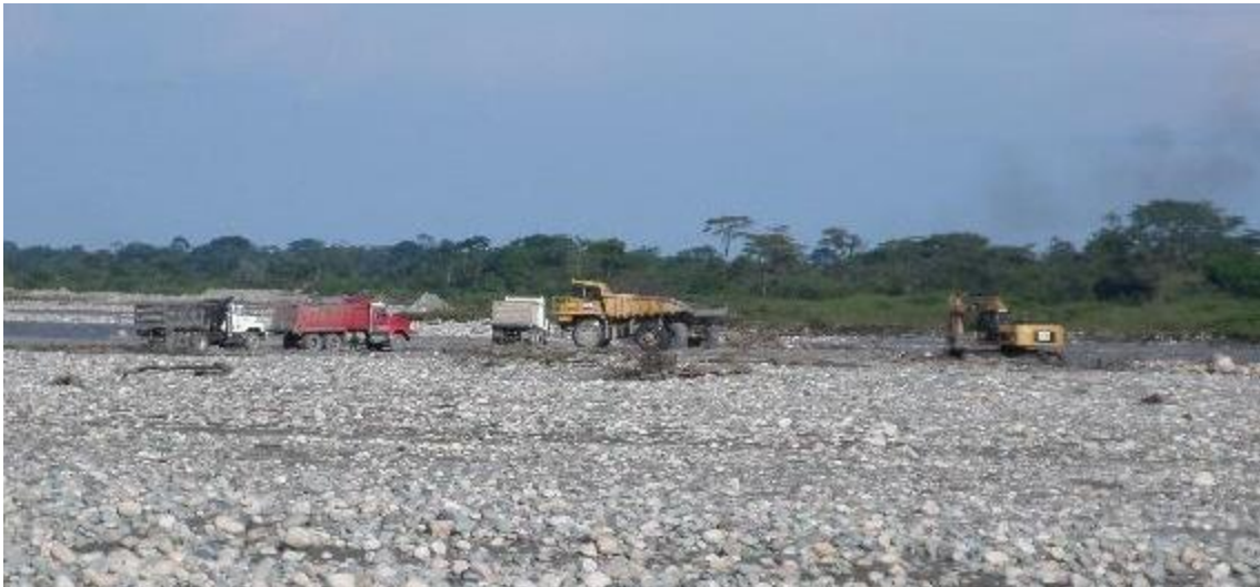
Fotografía 17-6 Extracción y transporte del material (Gravicon)
