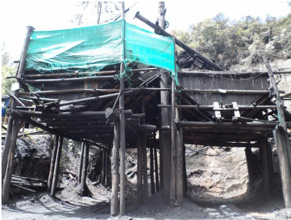
Fotografía 11-6 Estructura de la mina
