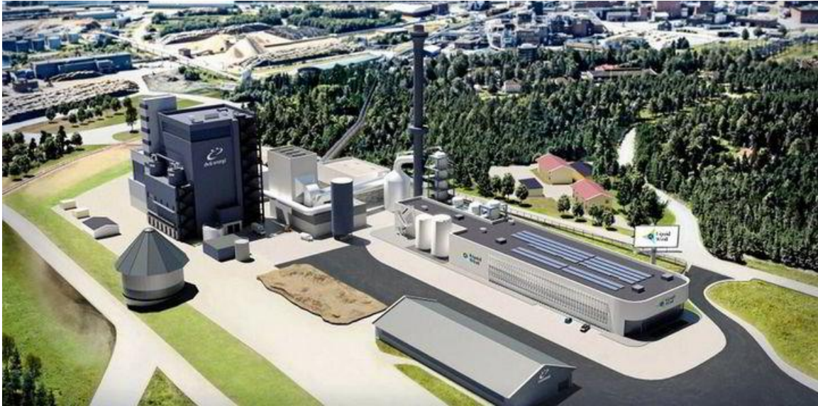
Imagen: Planta de exportación de e-metanol en Örnsköldsvik, Suecia Fuente: https://www.rechargenews.com/energy-transition/orsted-takes-big-stake-in-pioneering-e-methanol-plant-to-turn-shipping-greener/2-1-1143288
