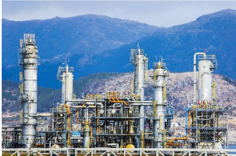
Imagen: vista de planta de captura de CO 2 de Mongstad en Noruega Fuente: https://norwegianscitechnews.com/2019/10/this-is-what-you-need-to-know-about-ccs-carbon-capture-and-storage/
