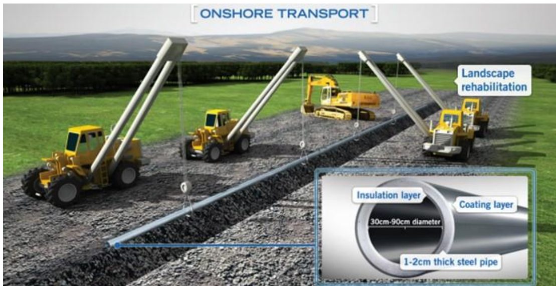
Figura 19 imagen de colocación de tuberías de CO2
