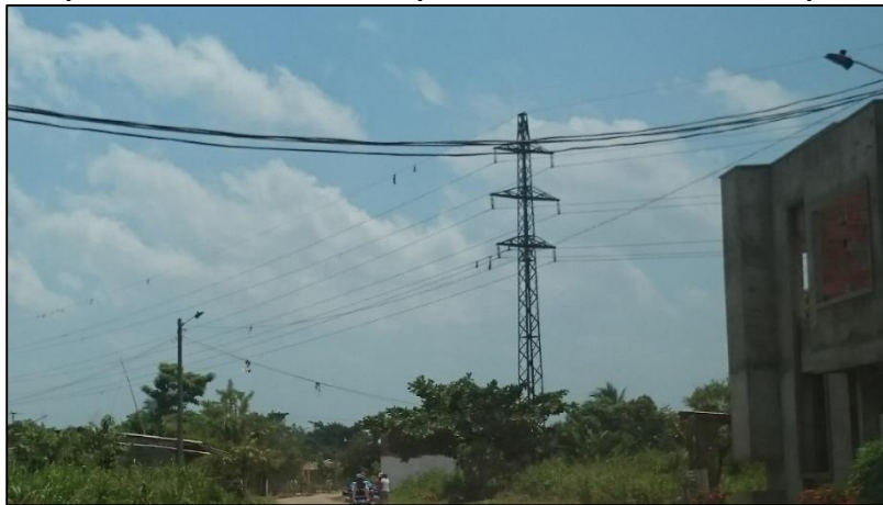
Figura 5. Vista posterior del sitio donde es posible la ubicación del nuevo pórtico de 110 kV
