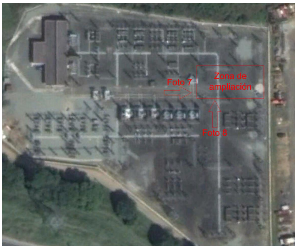
Figura 6. Subestación Ancón Sur
