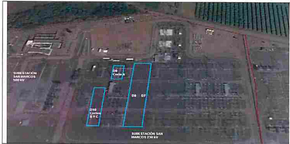
Figura. Espacios disponibles subestación San Marcos 230 kV.
