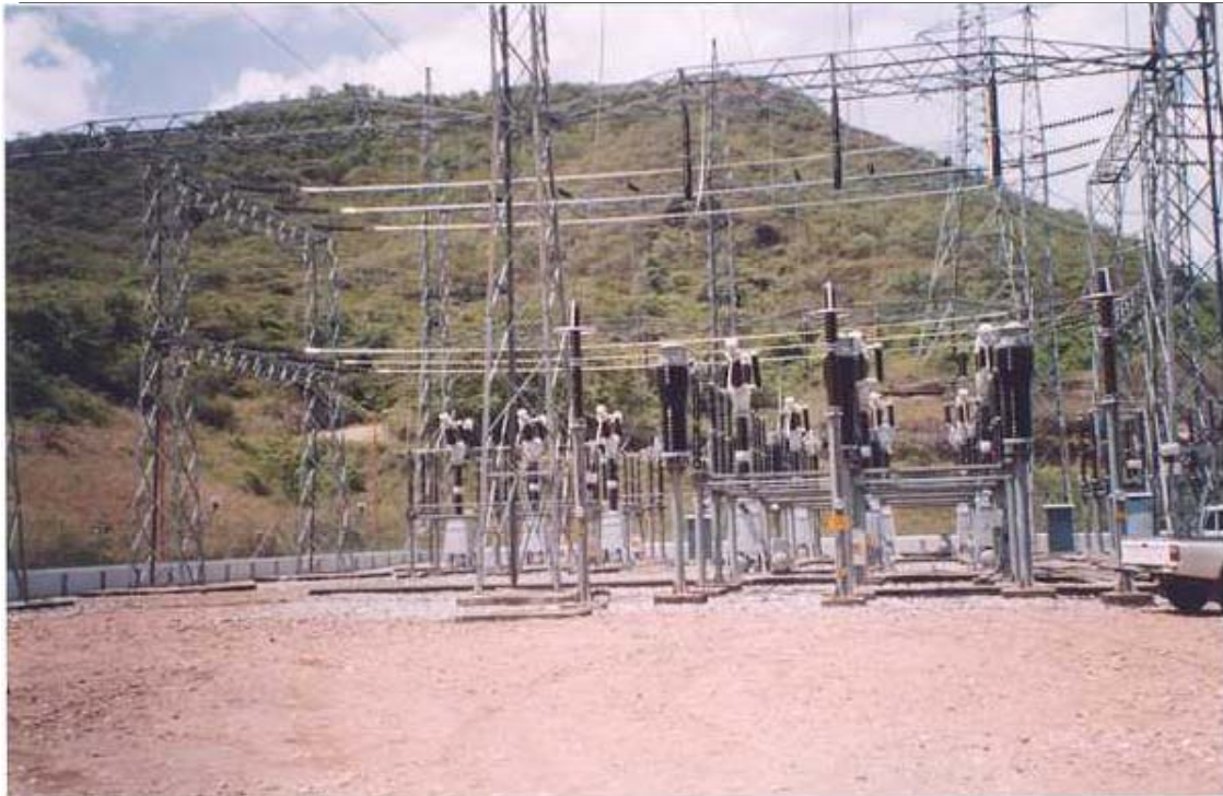
Foto N° 1 (S/E Betania). Desde puerta de acceso, lado oriental. Barraje principal 230 kV. En sentido oriente – occidente entran líneas desde la planta de generación. Por la parte posterior salen circuitos hacia San Bernardino y Mirolindo. En la parte frontal se observa el área disponible para la instalación de las nuevas bahías de 230 kV y posibilidad de ampliación hacia el costado izquierdo.
