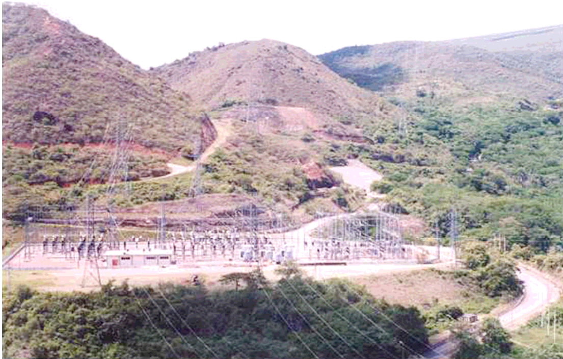
Foto N° 7 (S/E Betania). Desde costado oriental. Subestación. Parte posterior salida de circuitos hacia San Bernardino y Mirolindo. Parte frontal - centro salida circuito hacia El Bote. Parte frontal – derecha salida del circuito hacia Altamira. A la izquierda de la casa de controles está el acceso, el área disponible para bahías de 230 kV y la posibilidad de ampliación.
