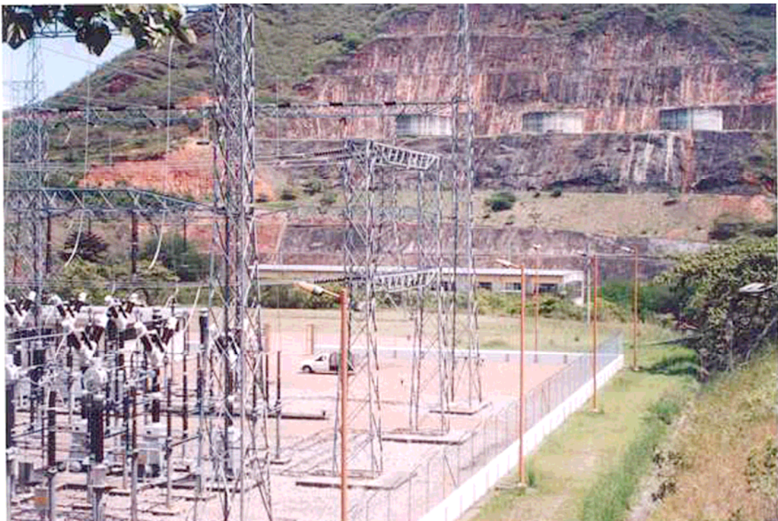
Foto N° 14 (S/E Betania). Desde costado occidental. Vista área disponible en el patio de 230 kV y áreas para posible ampliación.
