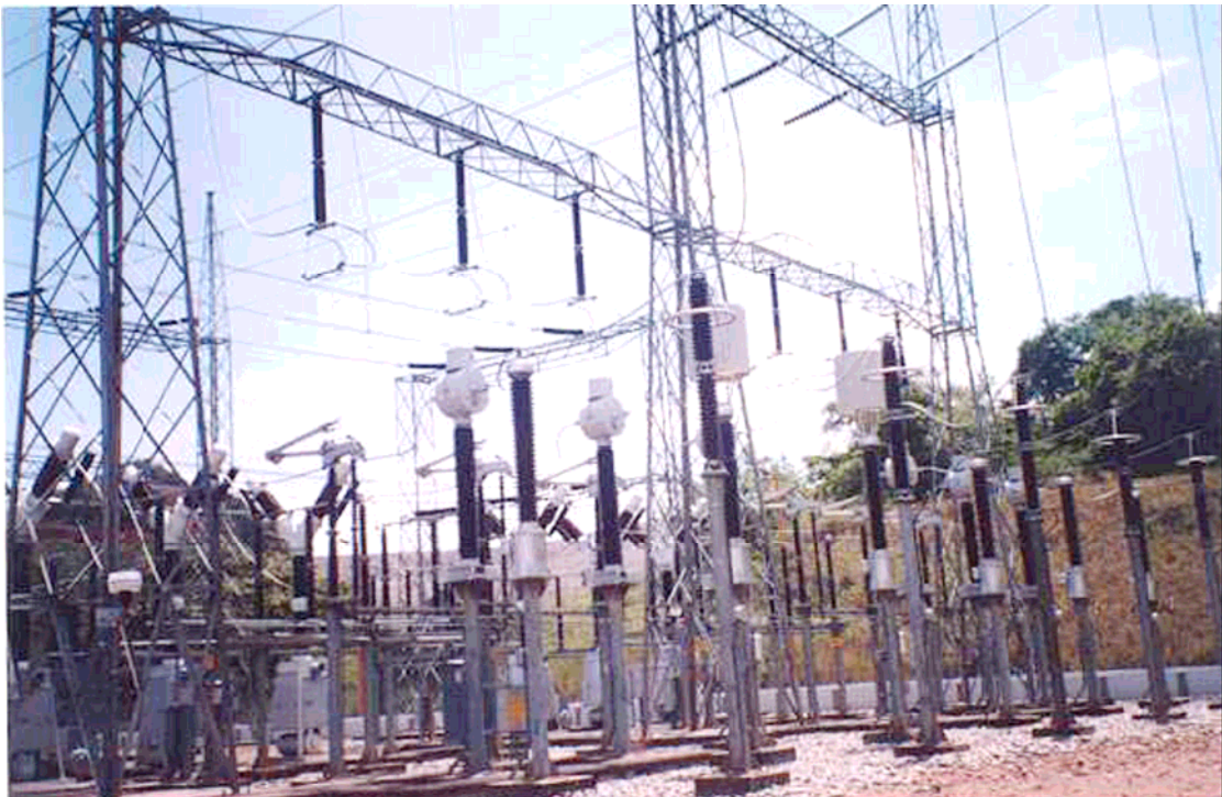
Foto N° 2 (S/E Betania). Vista barraje principal 230 kV.
