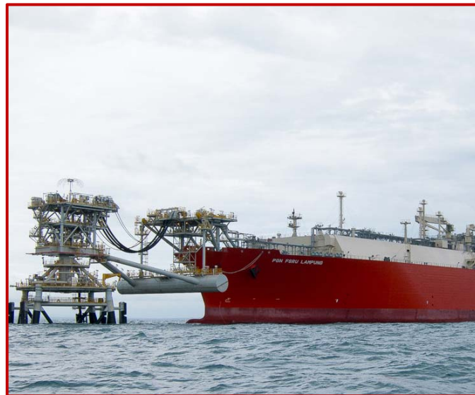
Conexión tipo "Turret" superficial para envío de GNL regasificado a tierra
