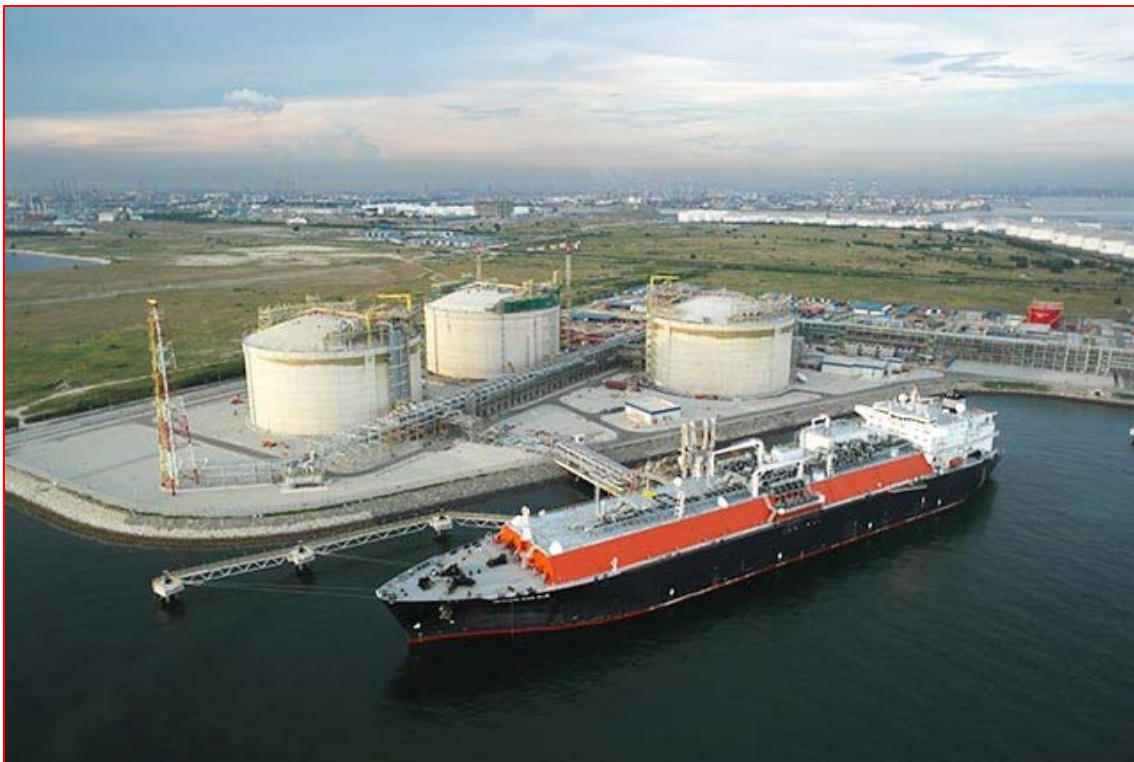
Figura: Descarga de un carrier de GNL a tanques de almacenamiento de GNL
