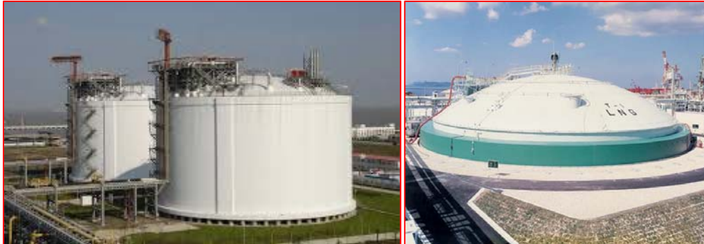
Figura: Tanque de almacenamiento de GNL aéreo (izda.) y enterrado (dcha.)
