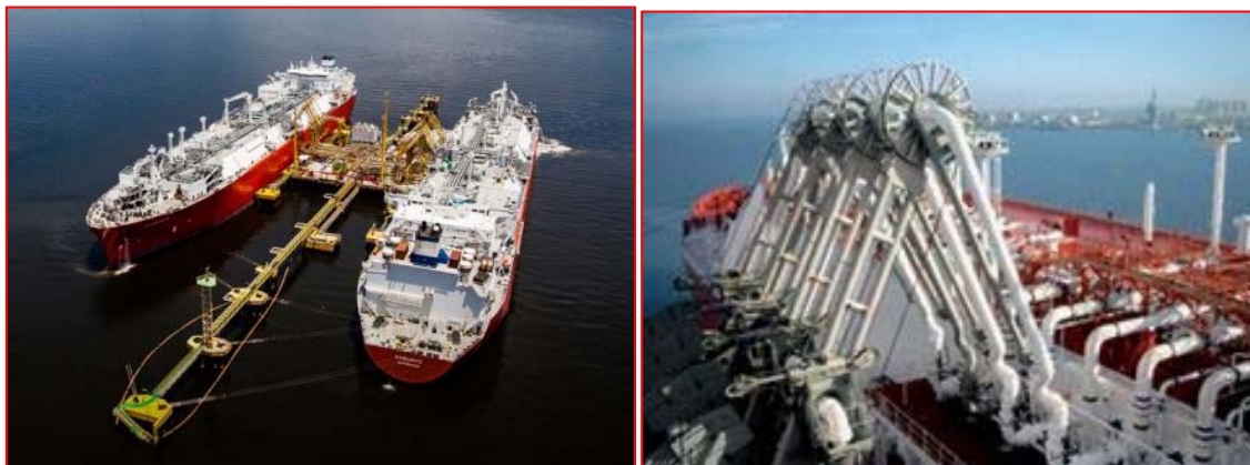
Figura: Descarga a través de jetty. Transferencia de GNL con brazos de descarga.
