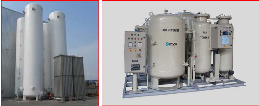
Figura: Unidad de vaporización de N 2 líquido frente a planta de obtención de N 2 tipo PSA
