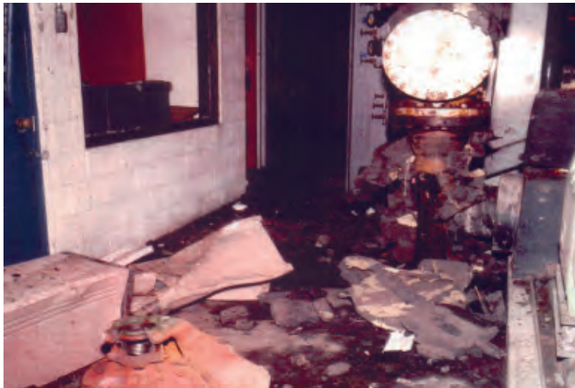
Figura 6.2 Explosión debida a válvulas cerradas a ambos extremos de la bomba
