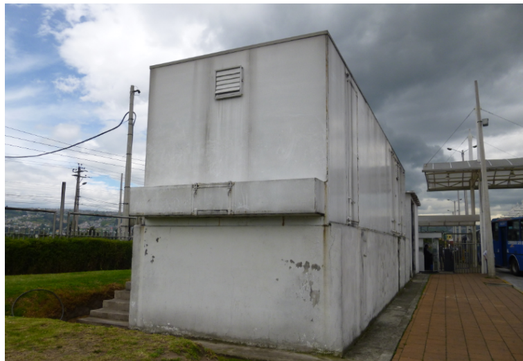
Fotografía 2-9. Subestación eléctrica en patios Quito (Velandia, 2015)
