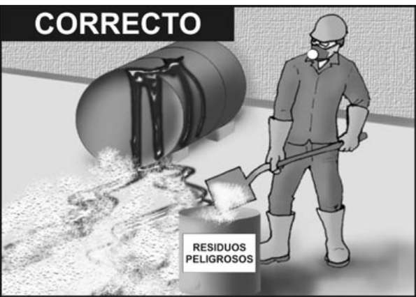
Figura 35. Manejo de derrames. Todos los derrames deben ser tratados inmediatamente. No se debe usar agua para drenar el material derramado. Se debe utilizar materiales absorbentes y recoger los residuos.
