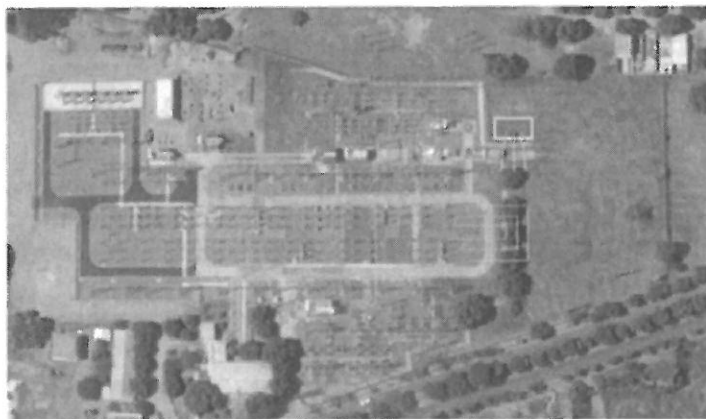
Figura 3 – Ampliación de barra 220 kV en dos diámetros.
