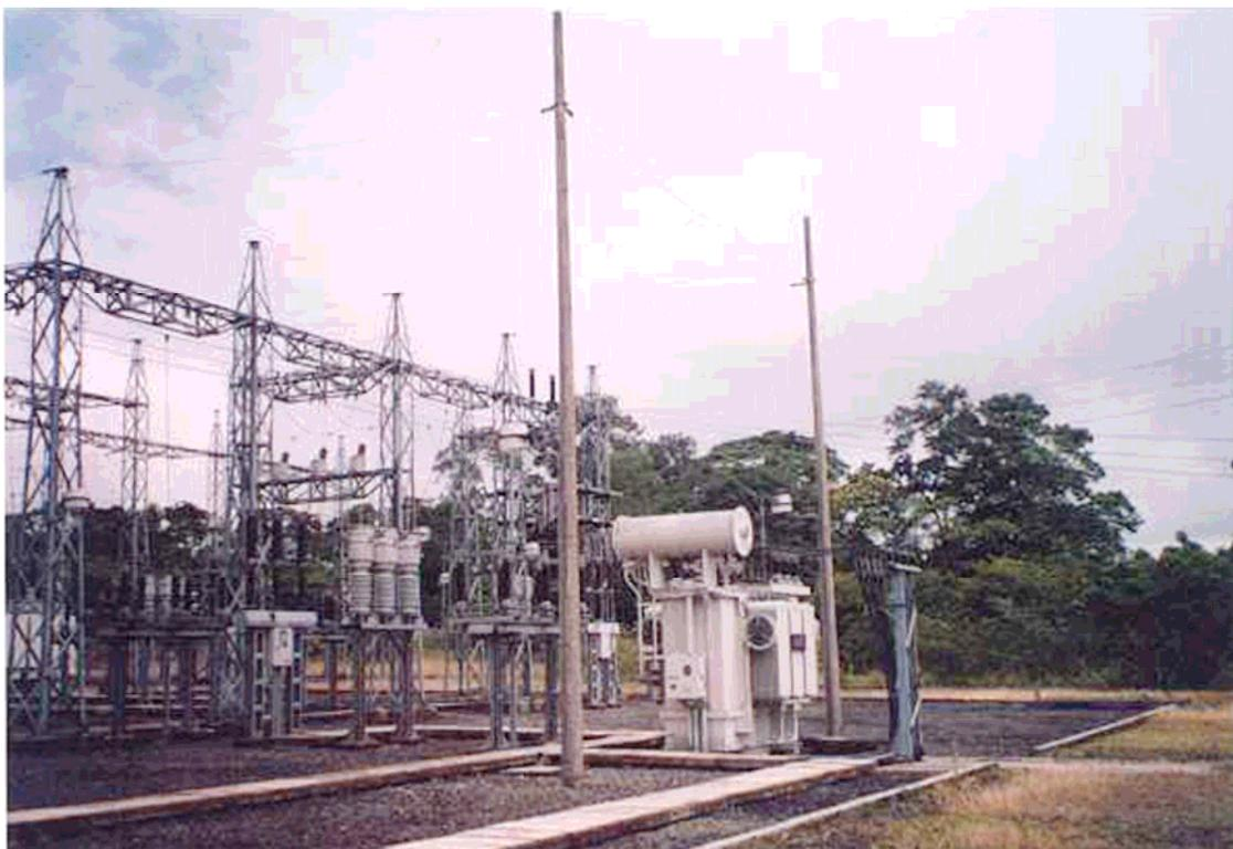
Foto N° 22 (S/E Mocoa). Vista transformador 115/34.5 kV
