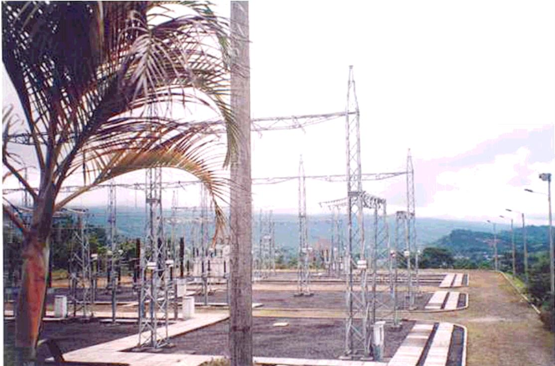
Foto N° 19 (S/E Mocoa). Vista patio de 115 kV. Barra principal parte delantera. Espacio disponible en 115 kV.
