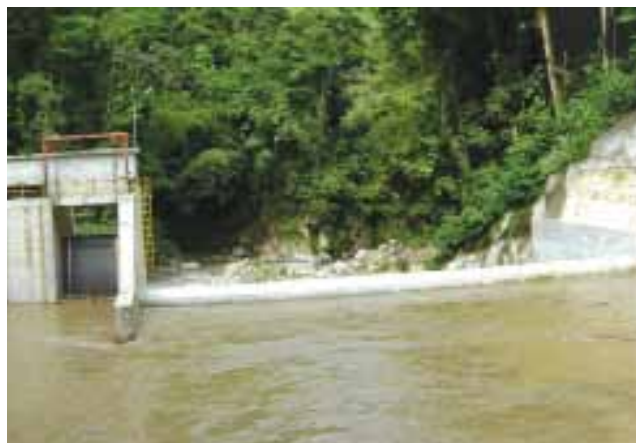
Proyecto Guarinó. Captación. Fuente: ISAGEN.
