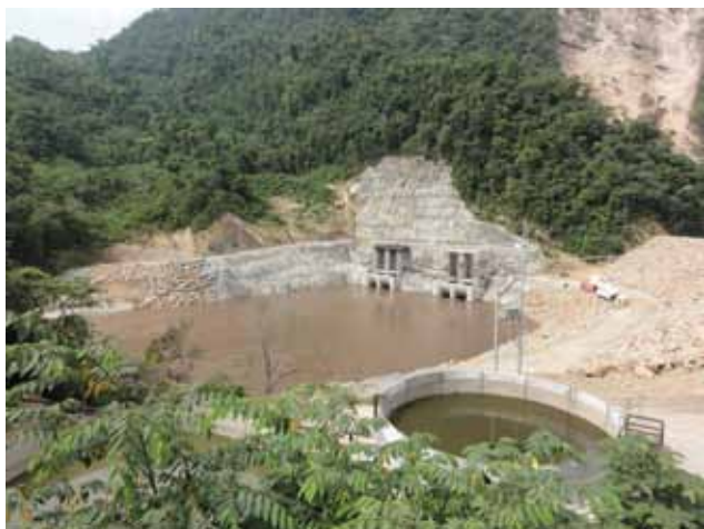
Proyecto Sogamoso. Aspecto del río entrando por los portales de entrada de los túneles de desvío. Sobre la derecha se aprecia el enrocado de la pretaquí. Fuente: ISAGEN.
