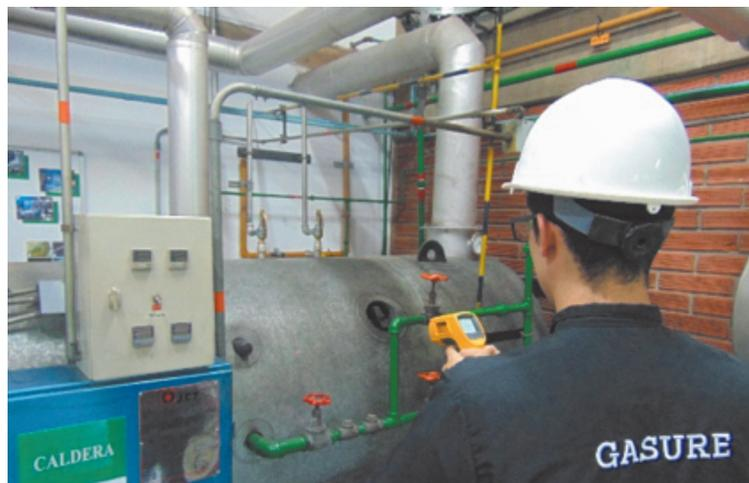
Figura 29. Uso de un pirómetro en una evaluación de un sistema de vapor
